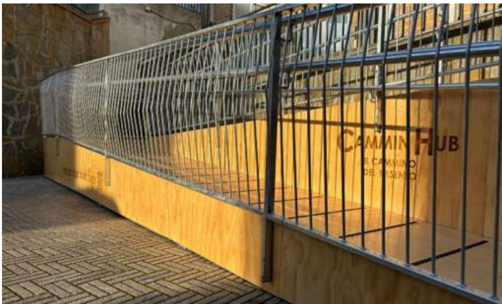
Figura 4. Rampa di accesso del CamminHub, Oliveto Lucano.
